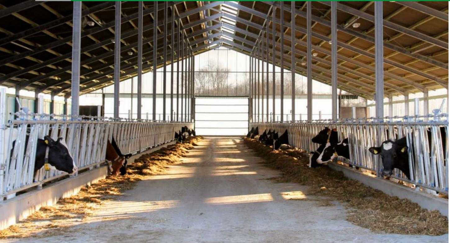
Tore mit Geweben sind besonders leicht und trotzdem stabil. Mit der Wahl des richtigen Gewebes lassen sich zusätzlich Lüftungseffekte realisieren. Die Tore öffnen grundsätzlich von unten nach oben. Es werden verschiedene Torvarianten angeboten: mit Handwinde bzw. elektrisch, mit bzw. ohne seitliche Führung, mit bzw. ohne aussteifende Querstreben.
