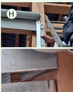
H) Befestigung der Führungsschienen (4) mit Torx-Holzschrauben 6 x 60.
