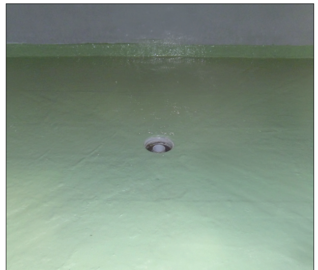
Die Beschichtung wird 3-4 mm stark angebracht.
