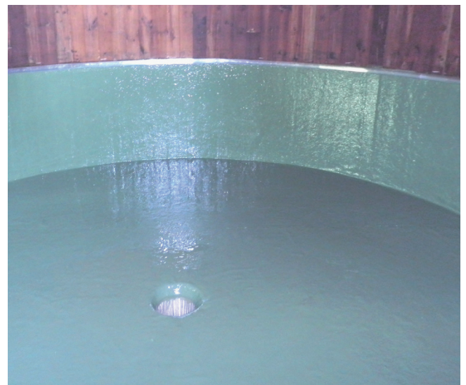
Die Beschichtung wird 3-4 mm stark angebracht .
