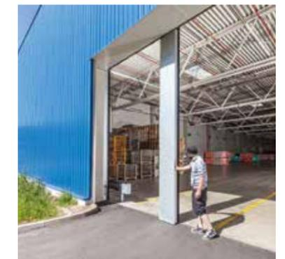
Durch das spezielle Laufschiensystem lässt sich der entriegelte Mittelposten einfach manuell an den Rand schieben. Beide Tore werden geöffnet und die Ausfahrt kann ohne grosses Rangieren passiert werden.
